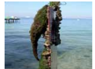
Antifouling uygulanmamış arka yüzey yosun ve 7 cm kadar kekamoz yapmıştır.
